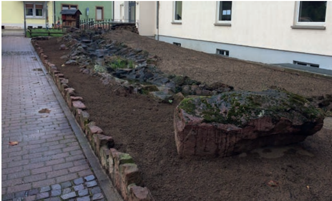
Der Bachlauf ist fertiggestellt, die Blümmischung eingesät. Im Oktober werden noch die Bodendecker gepflanzt. Foto: Stadt Eppelheim
