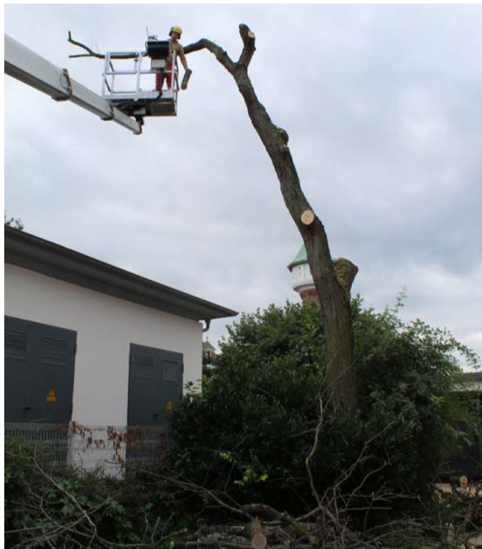
Der Mitarbeiter einer externen Firma fällt fachgerecht die Gleditschie im Durchgang zwischen dem Schulhof der Theodor-Heuss-Schule und der Rudolf-Wild-Halle. Der Baum war so geschädigt, dass die Verkehrssicherheit nicht mehr bestand. Foto: Stadt Eppelheim
