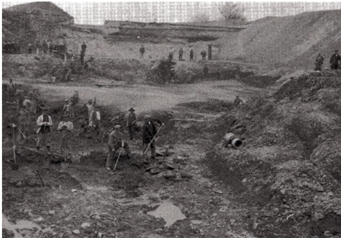
Ausbau der Eppelheimer Abwassergrube im Rahmen der „Notstandsarbeiten“ 1931/32 (aus: Geschichte entdecken – Eppelheim).
