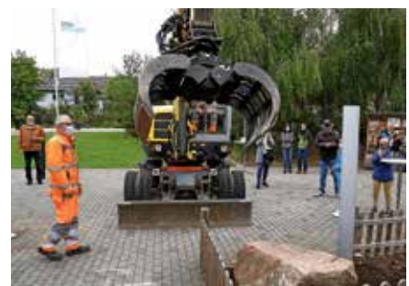
Ablegen des etwa 300 kg schweren Sandsteins Fotos: Geschwill Presseservice
