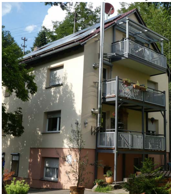
Energetisch auf Vordermann gebracht - ahezu alle Bauteile der Gebäudehülle dieses Zweifamilienhauses in Heidelberg wurden modernisiert und die Heizungsanlage erneuert. Foto: KliBa
